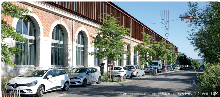
Campus Manufacture, le bâtiment des Forges. Crédit : UJM.
