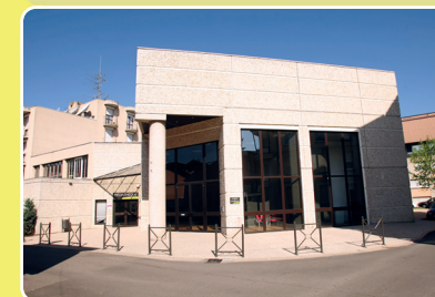
Maison de la Commune - FEURS
